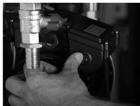
3. Fermer la vanne d'arrêt sur conduite de départ vers les points utilisateurs avec manomètre.
