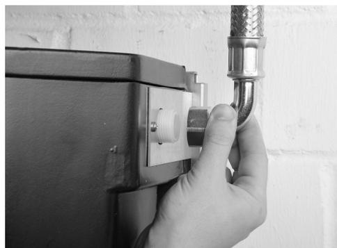
Visser l'autre côté du tuyau flexible au robinet d'arrêt monté à la conduite d'eau potable.
