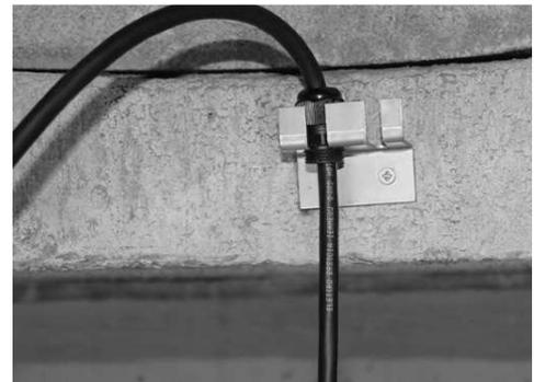
Le contre poids de l'interrupteur flottant sera fixé à une distance de  $A = 15 \text{ cm}$  au dessus de l'interrupteur flottant, pour qu'il puisse se déplacer librement autour du contre poids.
