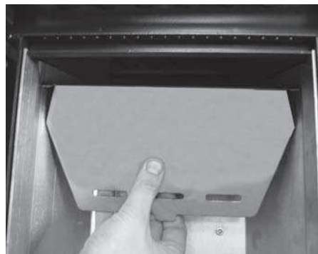
Fig. 16: rotação da placa corta-fogo
