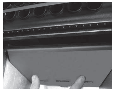
Abb. 14: Ziehen Sie die Feuerschutzwand hoch
