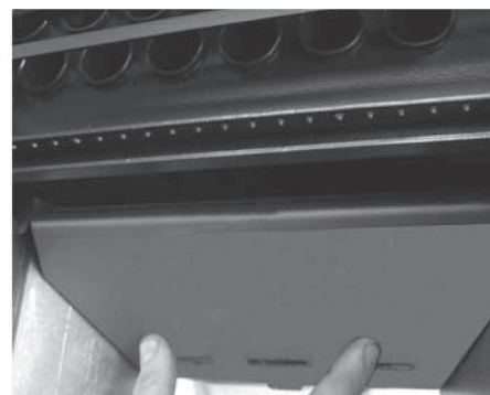
Fig. 14: levantar la placa cortafuego
