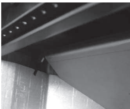
Fig. 15: soulever la plaque coupe-flamme
