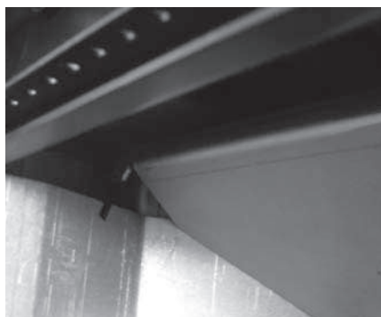
Fig. 15: soulever la plaque coupe-flamme
